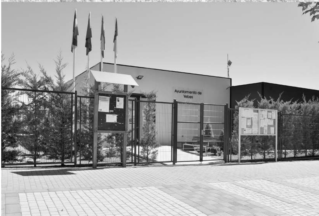
Edificio de servicios municipales de Valdeluz.
